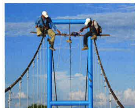
Toni og hans makker monterer wires på en bro.
