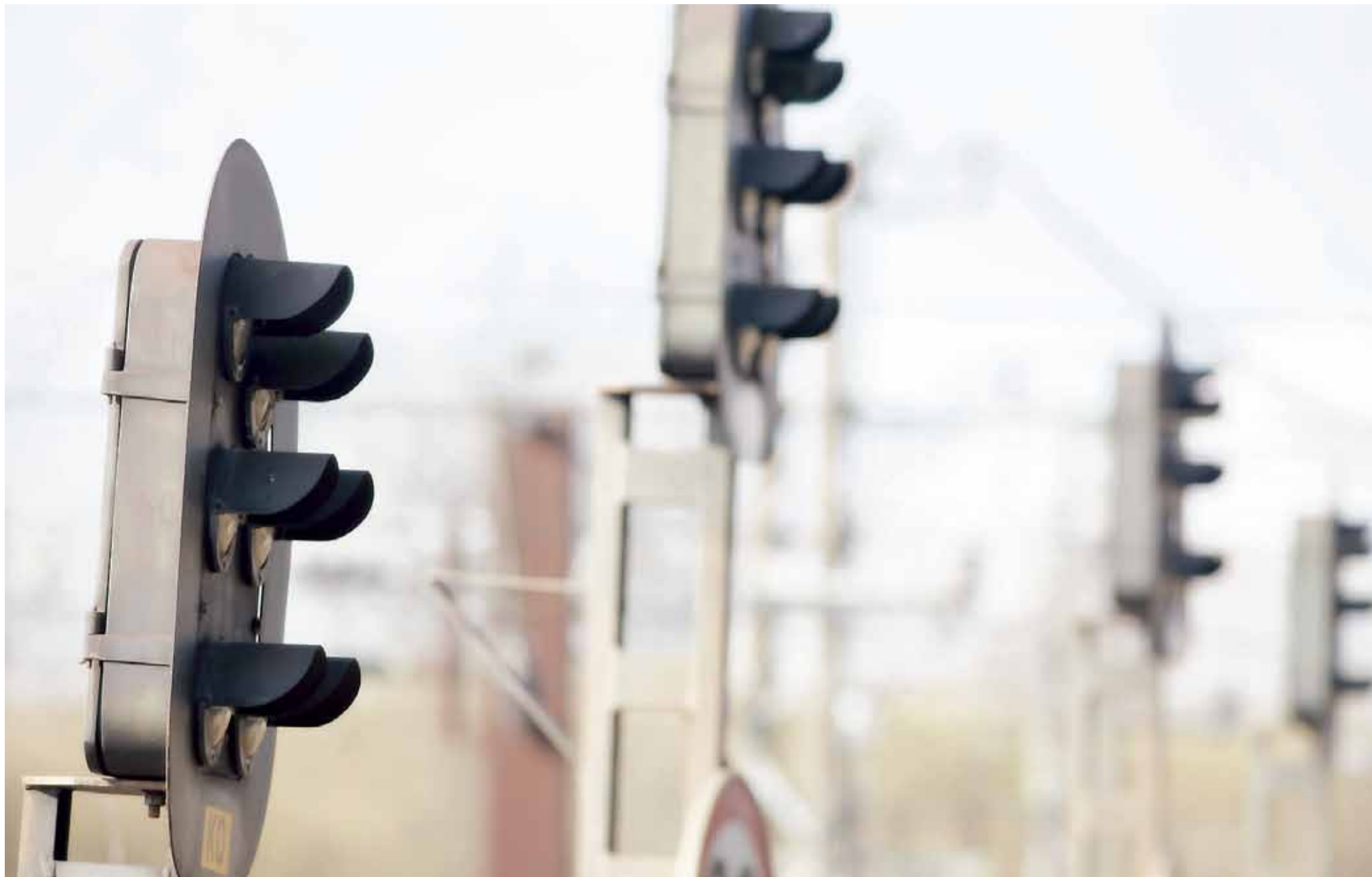
FREM TIL 2021 skal det forældede og visse steder udtjente danske signalanlæg langs Danmarks togskinnet totaludskiftes og erstattes med moderne, computerstyrede anlæg. Foto: Tao Lytzen
